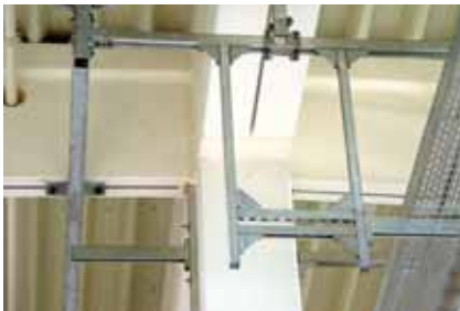
Wirtschaftliche und optimierte Lösung durch Kombination des 41er- und 63er- Systems Economical and optimised solution by combination of the 41 and 63 system
