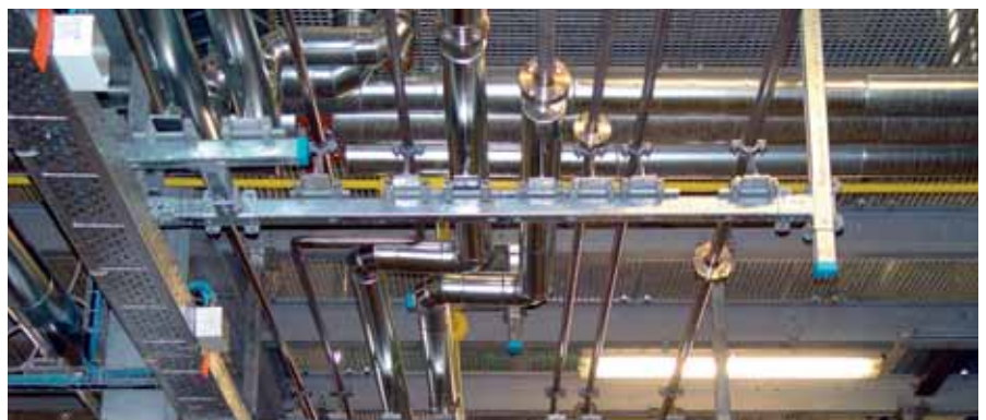
Trassenanwendung im Bereich Biodiesel Route application in the field Biodiesel
