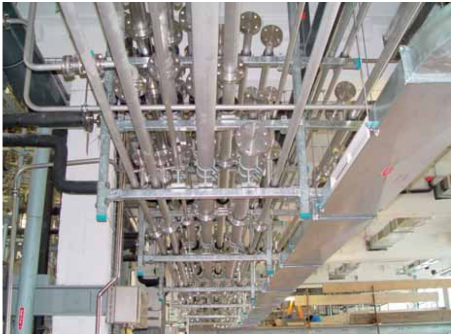
Optimierte Trassenanwendung in der Pharmaindustrie Optimised route application in the pharma industry
