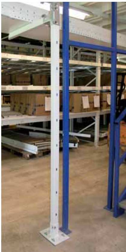
Aufgeständerte Kragarm-Unterkonstruktion für eine erweiterte Förderanlage Supported boom sub-construction for an extended conveyor system
