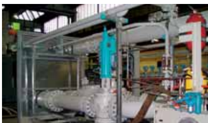
Direkter Verbau aller Komponenten mit feuer- verzinktem Material Direct installation of all components with hot-dip galvanized material
