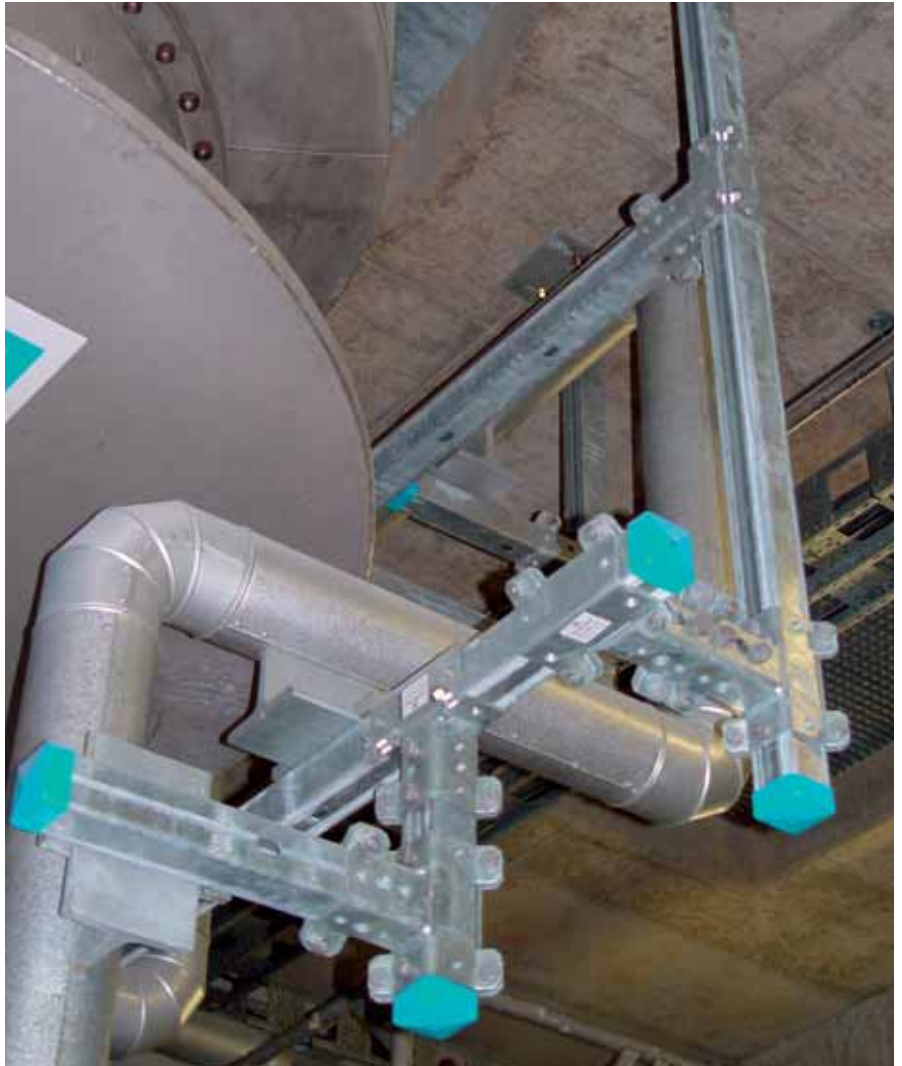
Flexible Anwendungen mit nur einer Schiene und 2 Verbindungsteilen Flexible application with only one profile and 2 connecting components
