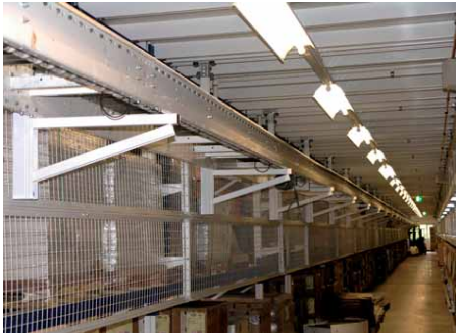
Transporttrasse mittels Powerclick System 63 und vormontierten Konsolen Transportation route with Powerclick System 63 and pre-assembled cantilever arms
