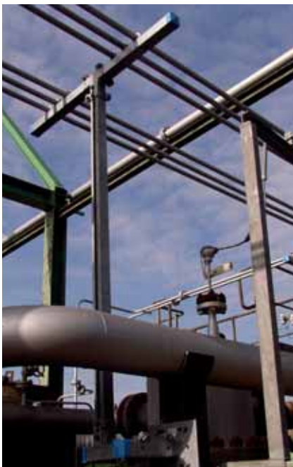
Justierbare Rohrunterstützungen im Außenbereich mittels flexibler Anbindung an vorhandenem Stahlbau External adjustable pipe supports allowing by flexible connection to existing steel construction
